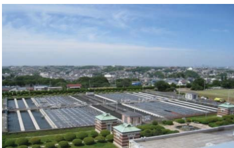
再整備を行う西谷浄水場
