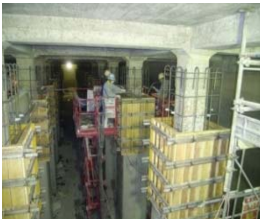
配水池の耐震補強工事
