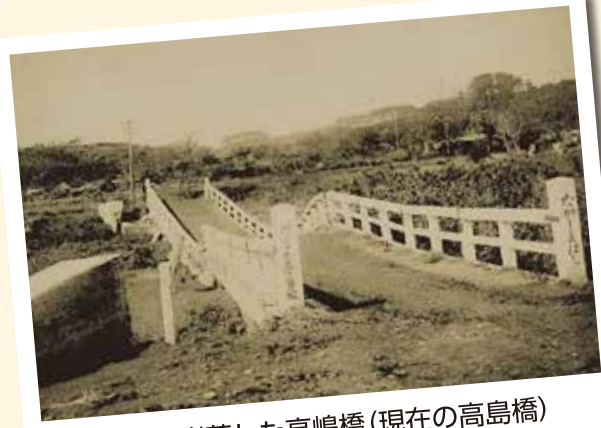
地震で崩落した高島橋(現在の高島橋)
