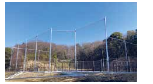
▲3月に完成した打越広場
