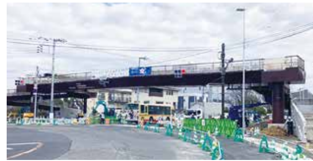
▲完成間近の歩道橋(3月7日時点)
