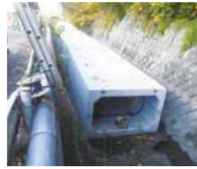
▲水路の地下化工事
