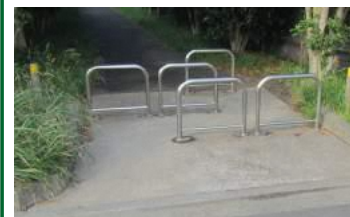
既設車止め (車いすやベビーカーの通行が困難)
