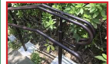
朝霧橋東側改修済みのデザイン手すり (本整備箇所と同じデザインの手すりを設置)
