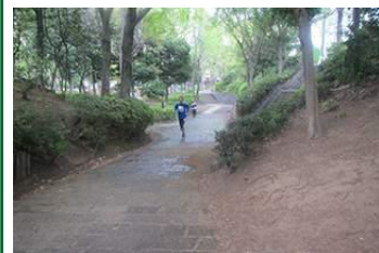
土が流れた現況法面
