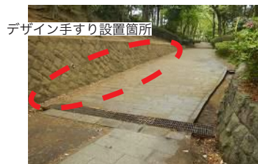
白河石舗装の、荒天時滑りやすい坂道
