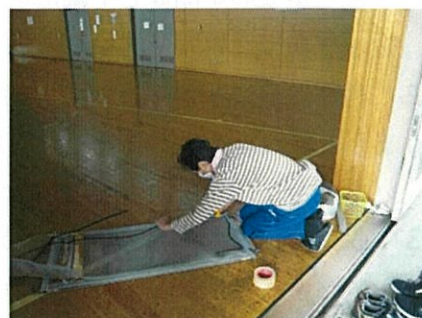
職員による網戸修繕
